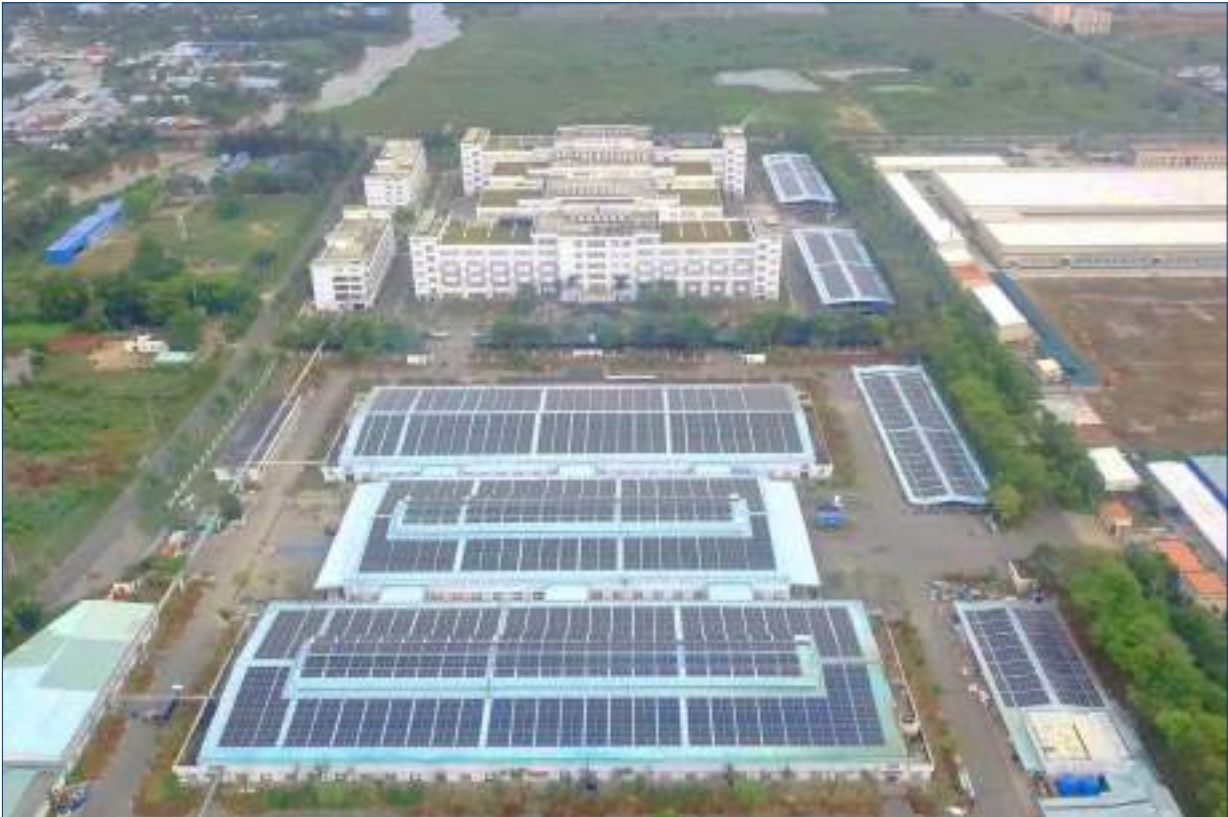
Nhà máy First Team có công suất lên tới 3.741,65 kWp.
