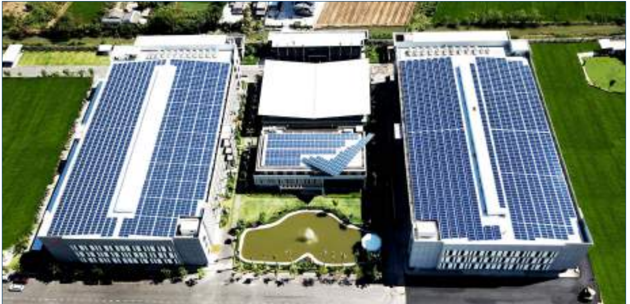
Nhà máy Việt Long Hung với công suất lắp đặt 1.100 kWp.
