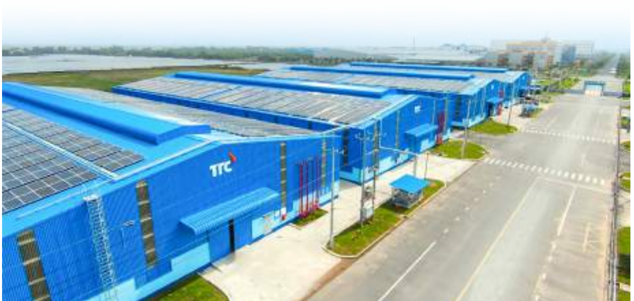
Đường nội bộ khu kho cảng rộng rãi từ 6 m - 12 m, đảm bảo lưu thông thuận tiện cho các phương tiện vận tải lớn.
