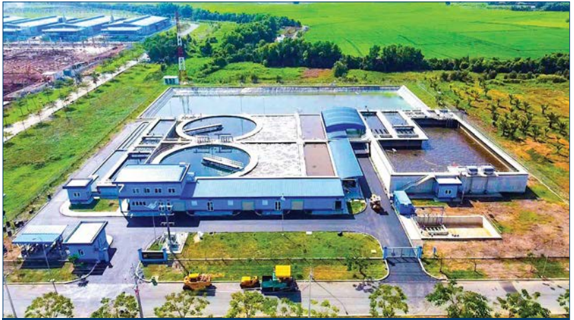
Nhà máy xử lý nước thải công suất 15.000 m 3 ngày/đêm.
